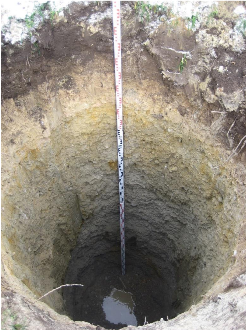
Brunnenbohrung – erster Blick auf das Grundwasser; © Umweltbundesamt / Franko Humer
