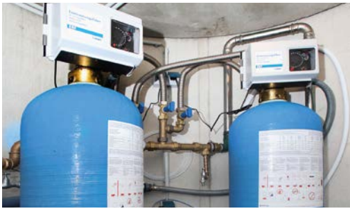
Beispiel einer Wasserenthärtungsanlage (Ionentausch-Verfahren)
