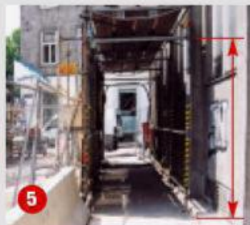
5 Durchgangshöhe bei Gerüsten und Passagen von mind. 2,20 m.
