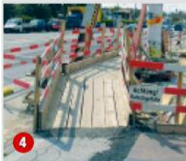
4 Ersatzgehsteig mit Abschränkung zur Fahrbahn mit Rampe.
