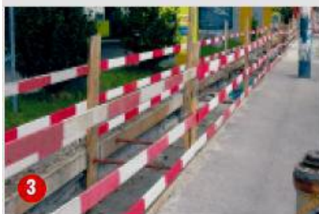
3 Abspernung bei Absturzgefahr mit zusätzlicher Latte.
