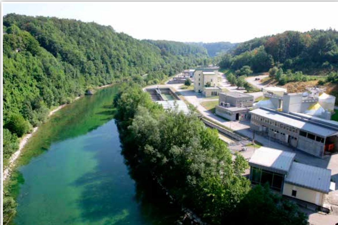
Kläranlage des RHV Traunsee Nord
