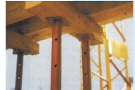
*Schalungsstützen müssen am Kopfende, manchmal sogar am Fußende, auf Schalungsträger angeheftet werden*
