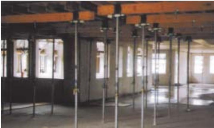
Bei großen Spannweiten ist es oft zweckmäßig, nach dem Ausschalen aus Sicherheitsgründen vorerst noch einige Stützen stehen zu lassen bzw. wieder anzubringen, um übermäßige Belastungen, die oft während des Baues auftreten, abzufangen.
