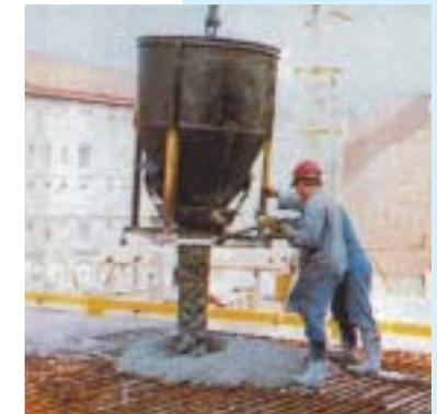
Die Entleerung des Betonierkübels soll möglichst knapp über der Decke erfolgen (nicht so hoch wie im Bild!)
