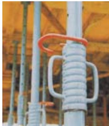
um Feststellen des ausziehbaren Oberteiles ist ein mindestens 12 mm starker Rundeisenstahldorn zu verwenden, der unverlierbar an der Stütze befestigt sein muss. Rippentorstahl oder Nägel sind kein geeigneter Ersatz und daher verboten.
