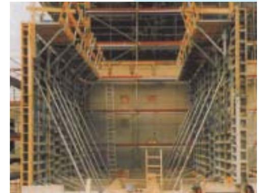
Schalungselemente sind nach dem Abstellen zug- und druckfest zu verankern oder mit standsicheren Elementen fest zu verbinden
