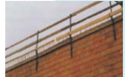
*Durch Einstecken der Geländerstangen in die Deckenabschalungshalter kann einfach und rasch ein Geländer errichtet werden*
