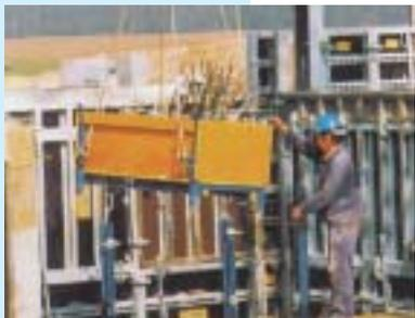
Zum Aufbewahren der Kleinteile werden entsprechende Behälter verwendet, die auch für den Krantransport geeignet sind
