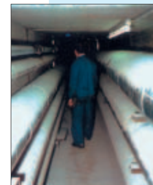
Kollektorgang – auch er kann ein Behälter sein
