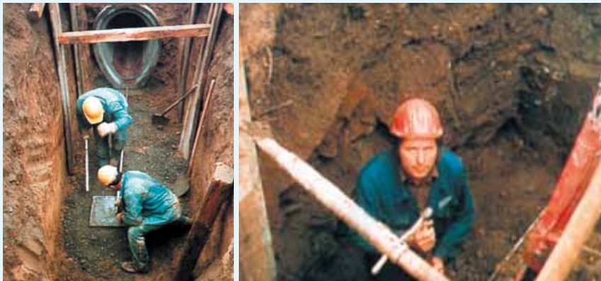
Hier besteht höchste Lebensgefahr. So darf nicht weitergearbeitet werden!
