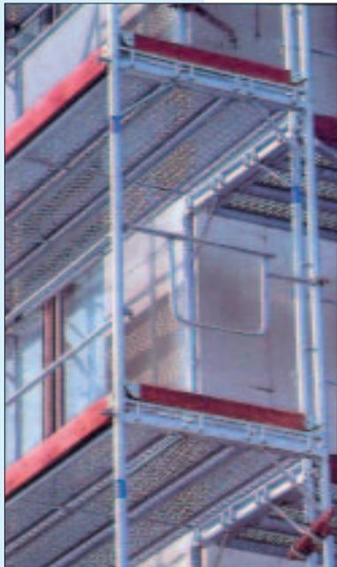
Steckgerüst mit Endabsicherung
