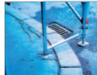
Niveausgleich durch Schraubspindeln
